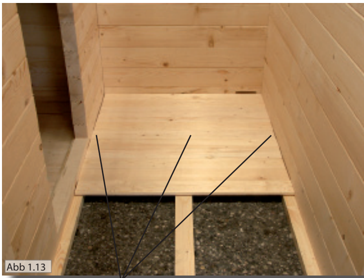
Fußboden - Schrauben 3,5 x 50 mm
