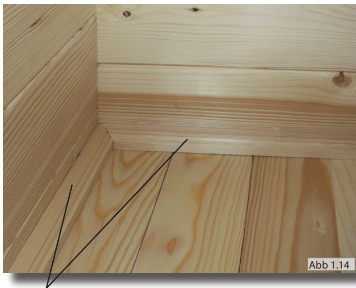
Sockelleisten - Schrauben 3,2 x 40 mm
